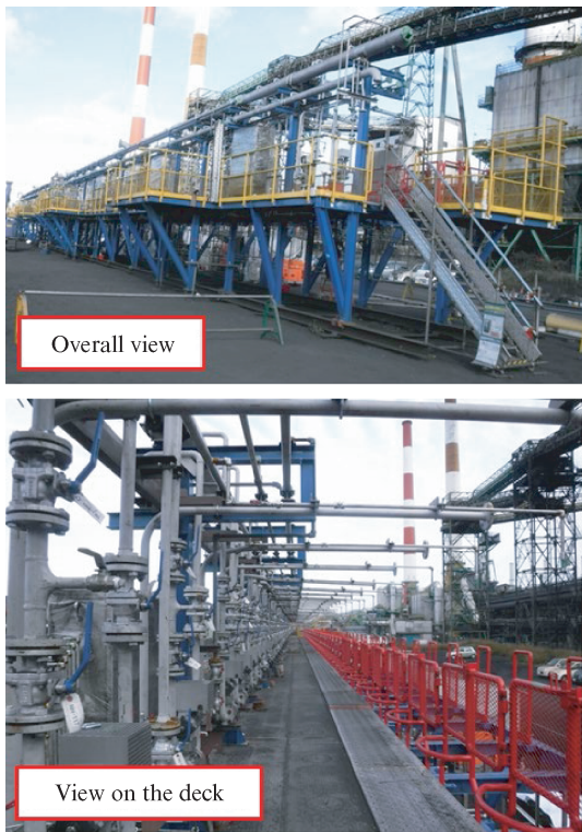
図7 事前艦装後のドライメイン周辺デッキ（一例）
